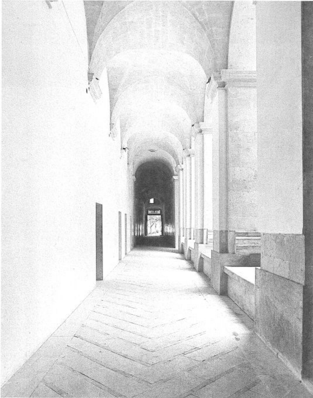
Il restauro del porticato
