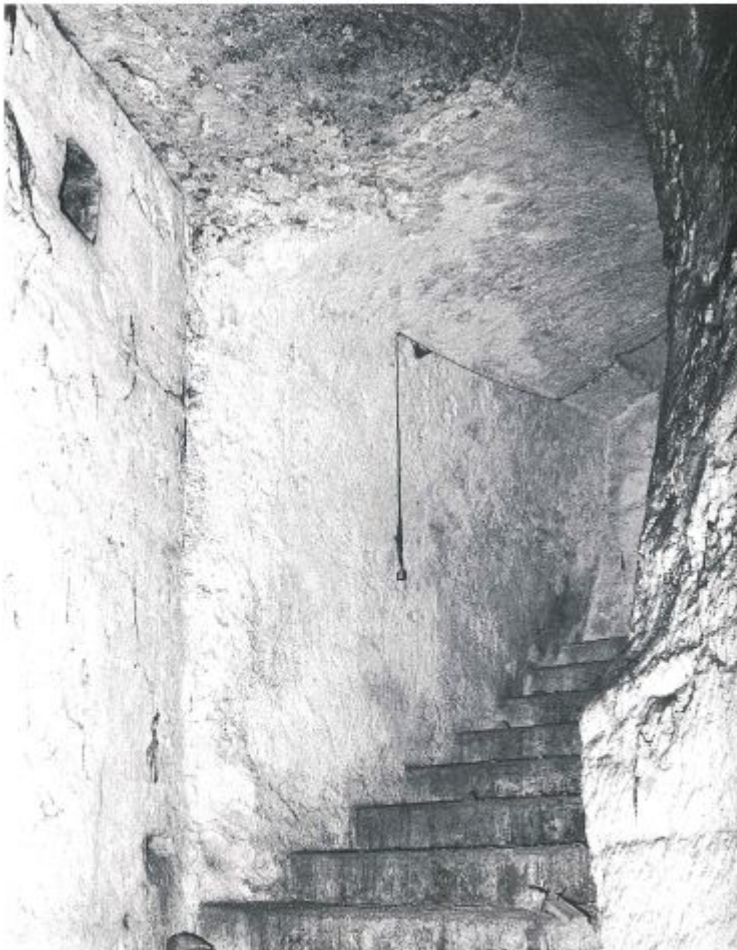
Il presente escavo della scalinata che attraversa tutto il sito
