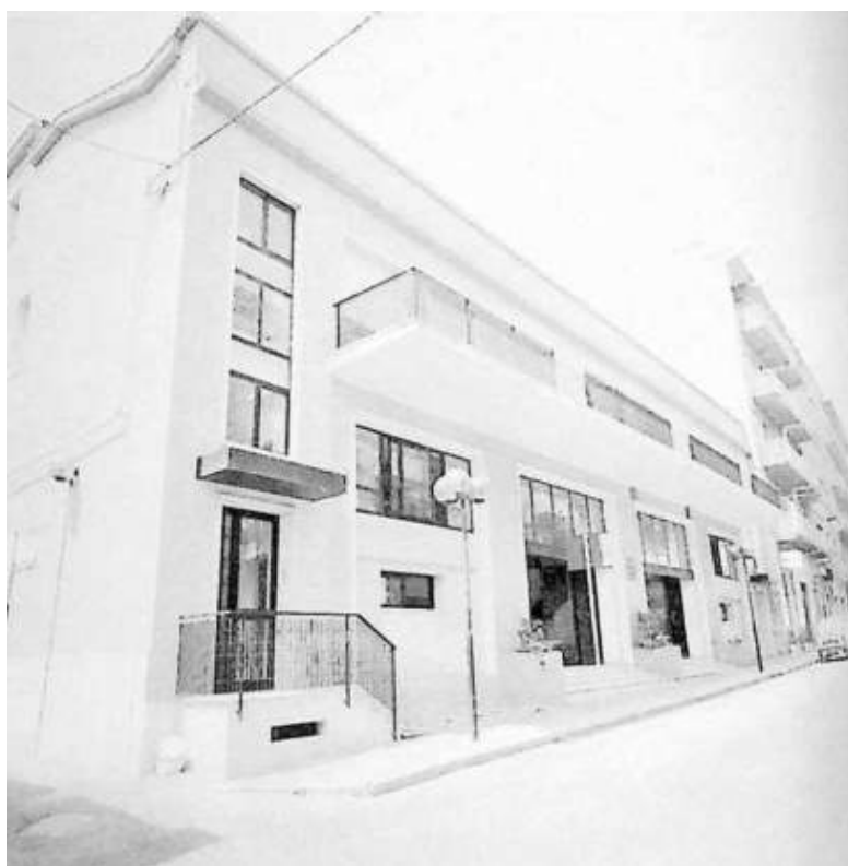
Sede di via T. Stigliani. Prospetto principale.
