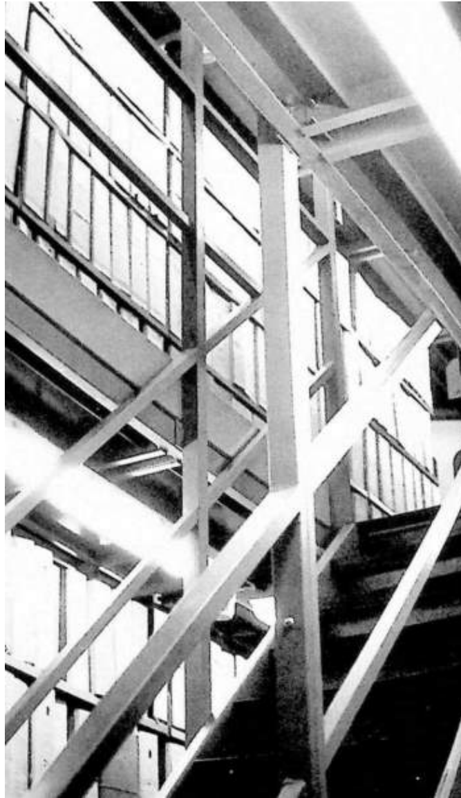
Sede di via T. Stigliani. Scala di collegamento ai diversi piani di scaffalatura del deposito.
