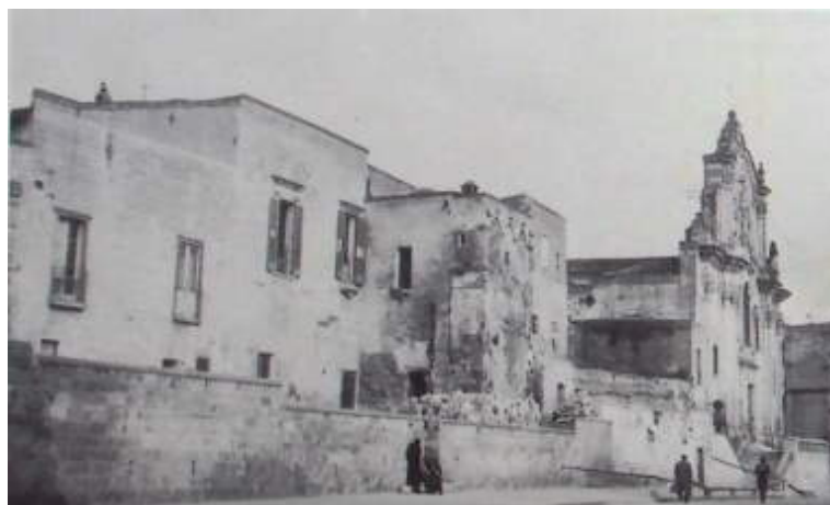
Alcune fasi dell'intervento novecentesco nella zona di Corso Umberto/Via Fossi.
