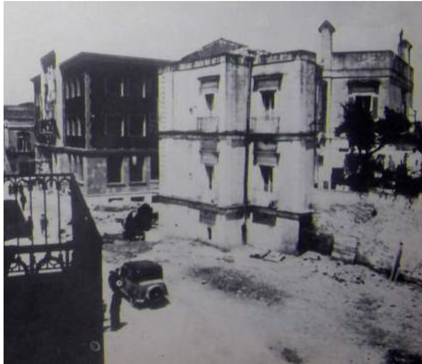
Corso Umberto e il Palazzo delle Poste durante gli interventi novecenteschi.
