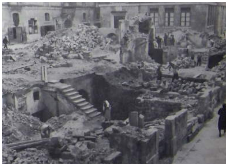
Due momenti della demolizione dei fabbricati preesistenti.
