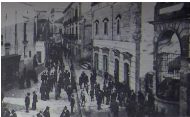
Il corso Umberto prima dell'intervento.
