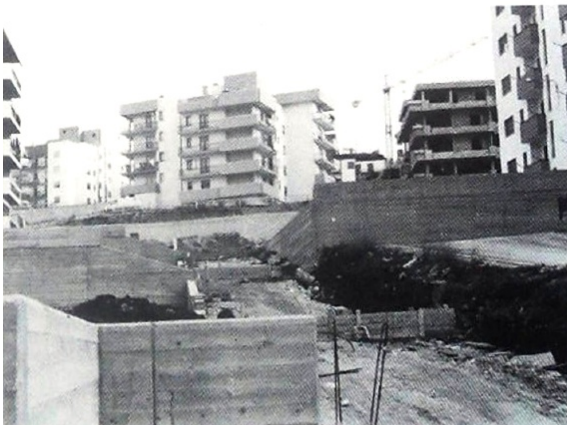
Foto d'interni con vista di cemento.
