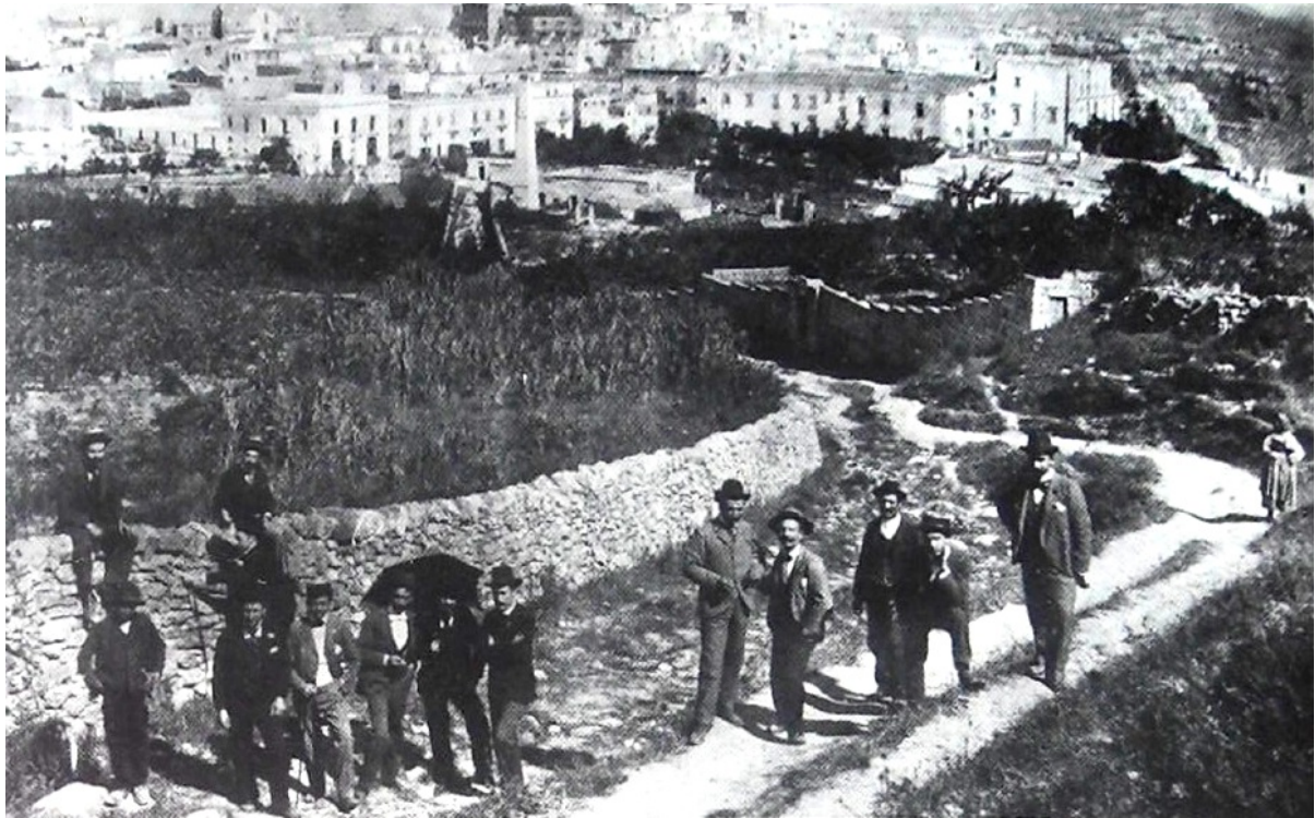
Immagine di Matera da via Caropreso all'inizio del secolo.
