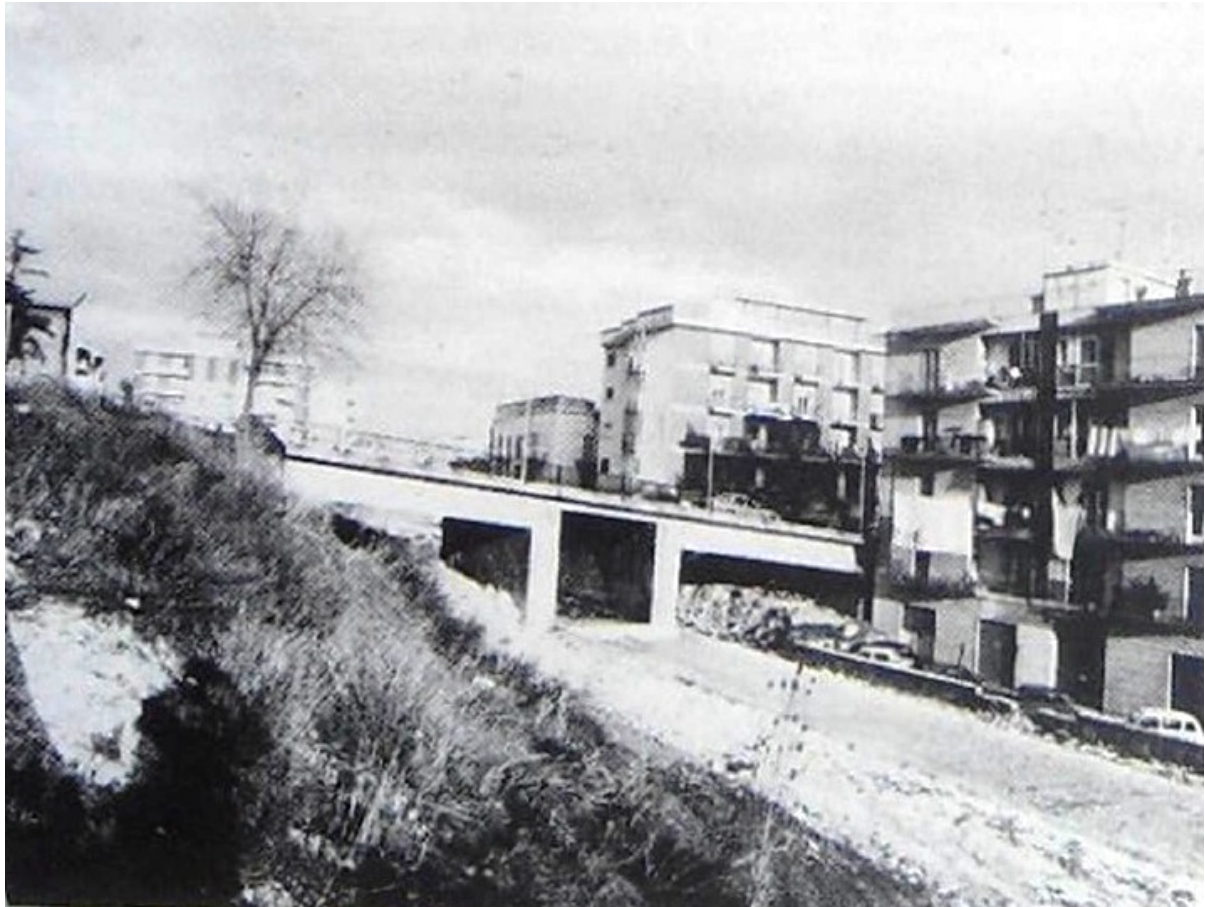
Il percorso interrato delle Ferrovie Calabro-Lucane: l'improbabile metropolitana.
